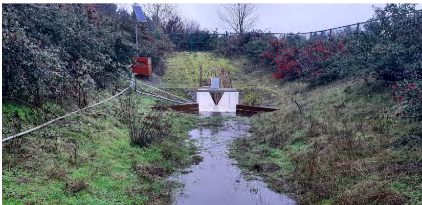
Figure 3. Vancouver bioswale effluent
